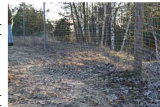
Unterwühlenschutz mit Knotengeflecht am Boden
